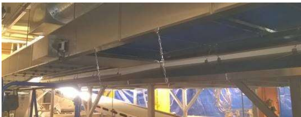
Bild 7: Svalbanan med inspektionssluckorna nedpendlade i kedjorna på ena sidan. Luckorna ligger på en klack och måste lyftas och dras åt sidan för att kunna fällas ned. Källa Polarbröd
