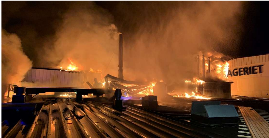
Bild 25: Kl 00:00 takkonstruktionen intakt men branden har spridit sig upp till samtliga ventilationsutrymmen och ventilcentraler som står på taket. Källa: Räddningstjänsten
