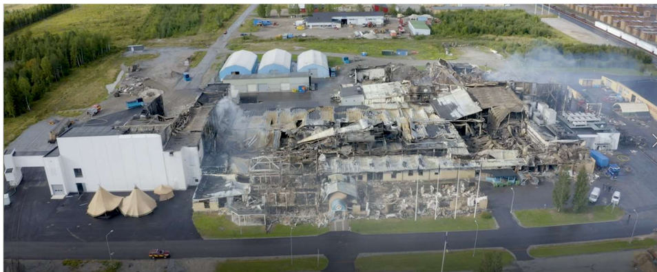
Bild 24: 2020-08-26 Visar anläggningen ett par dagar efter branden. Källa: Räddningstjänsten
