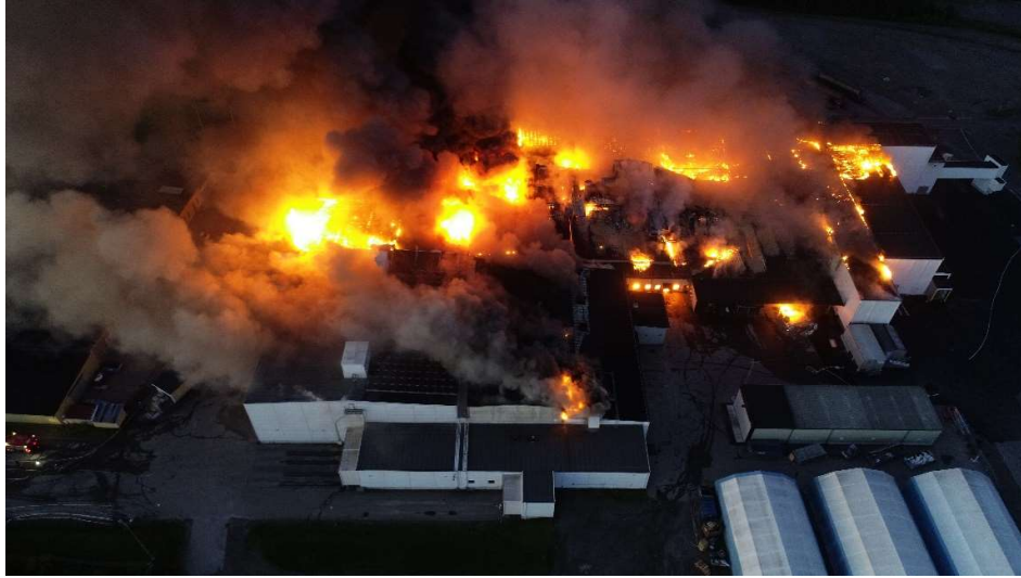
Bild 14: Kl 04:04 brand i hela byggnadskomplexet. Den kraftigaste röken kommer från cellplastisoleringen i paketeringen som tidigare varit ett frysrum. Källa: Räddningstjänsten
