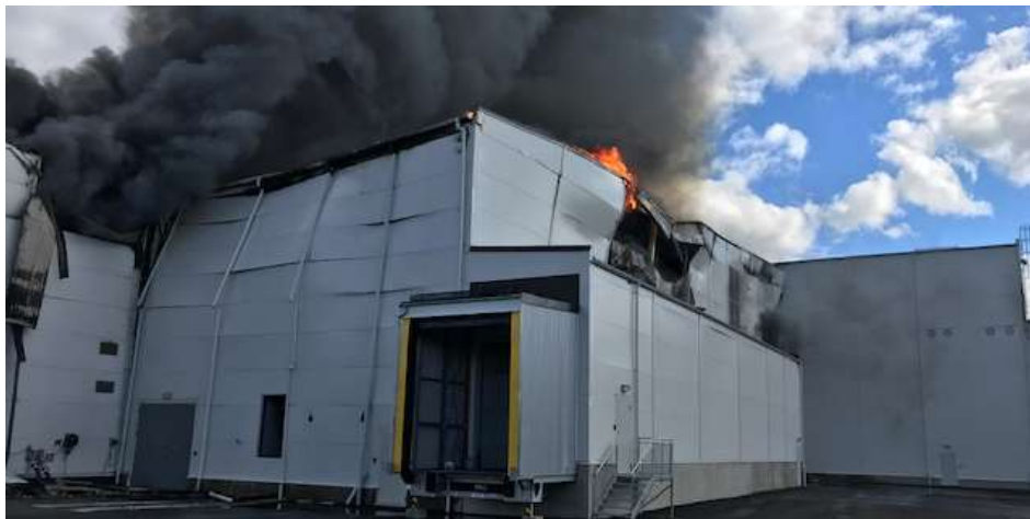
Bild 23: Kl 12:30 24/8 spred sig branden över brandcellsgränsen, E1120-M till det nybyggda råvarulagret.
