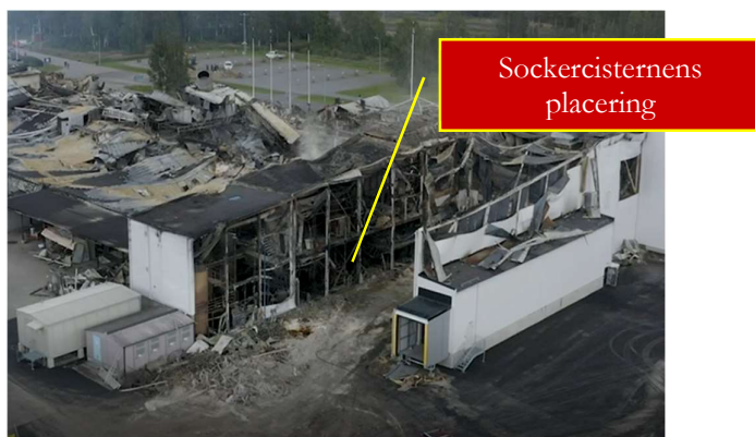
Bild 18: 40 m 3 Sockercistern av aluminium har utplånats Källa: Räddningstjänsten
