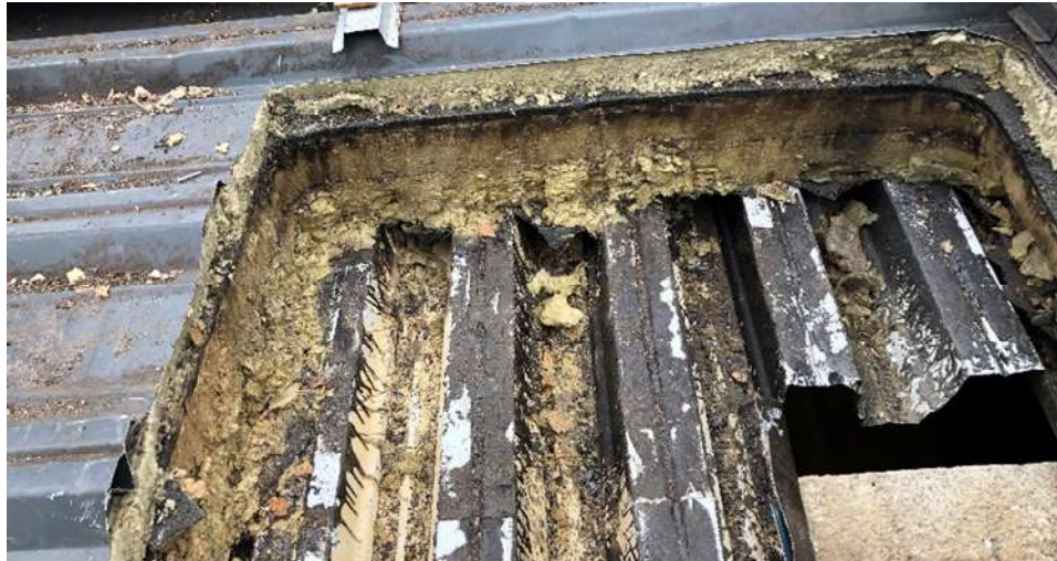
Bild 2: Visar taket i produktionslokalen som är den äldsta delen. Taket har byggts på vid två tillfällen på grund av läckage. Källa: Polarbröd
