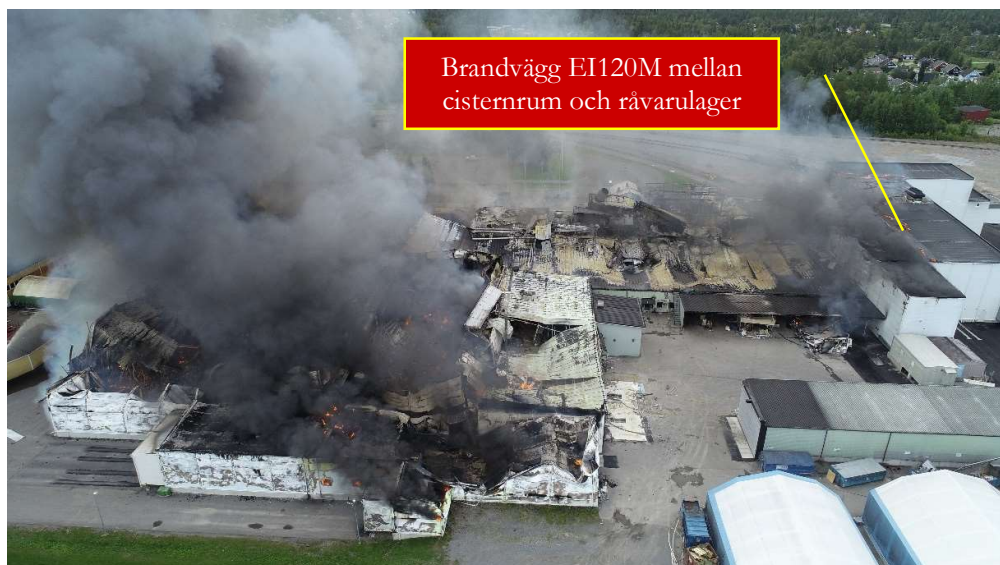
Bild 16: Kl 07:38 Bilden visar brandplatsen strax efter att arbetet återupptagits på morgonen. Källa: Räddningstjänsten
