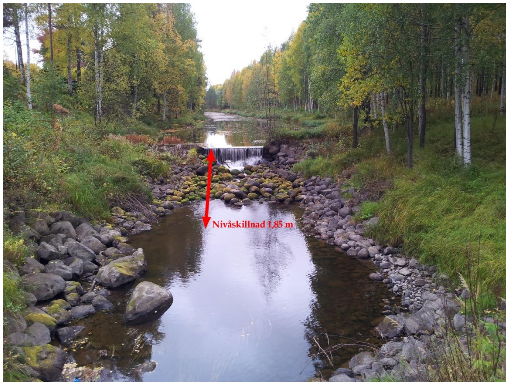
Nivåskillnad vid dammen vid lågt flöde i Pite älv.
